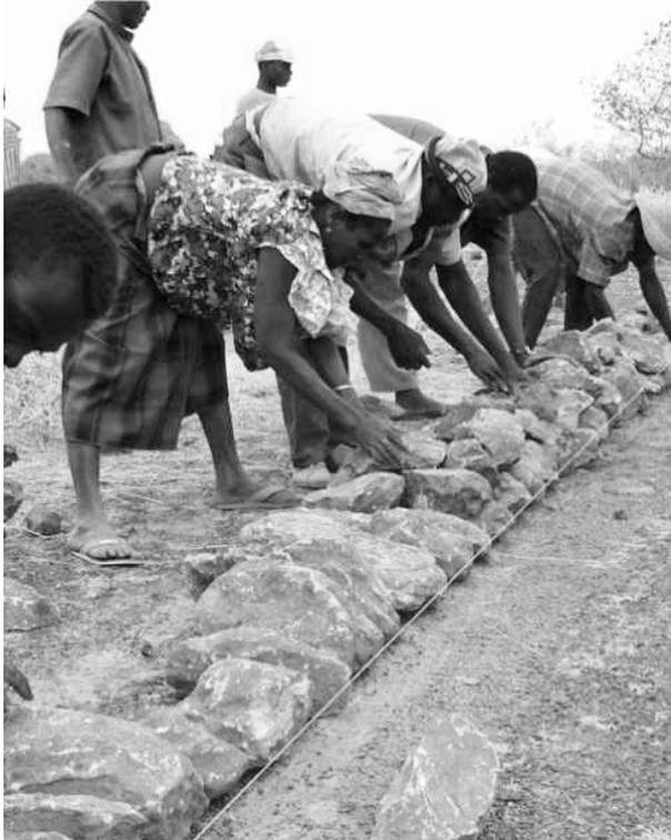
Bild 3.1: Bau eines Steinwalles zur Verminderung der Erosion
