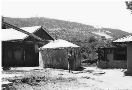
Bild 10.1: Eine einfache Konstruktion für das Auffangen und Speichern des Regenwassers von Dächern
